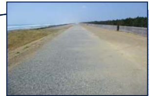
試験施工その2
